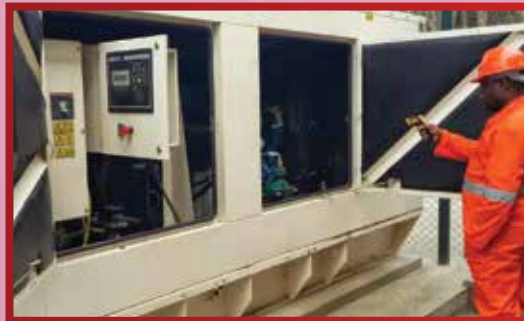
Manutenção de Grupo Geradores
